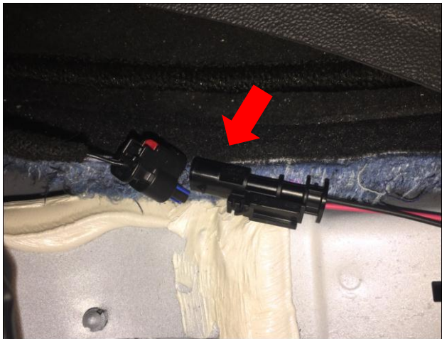
安装内饰件 拆卸的原车迎宾踏板接头还原安装；
