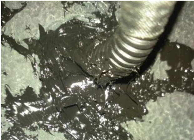
密封穿线孔：如图示意已涂密封胶（图片仅供参考）
